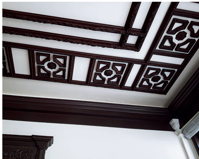
■ Particolare dei soffitti
